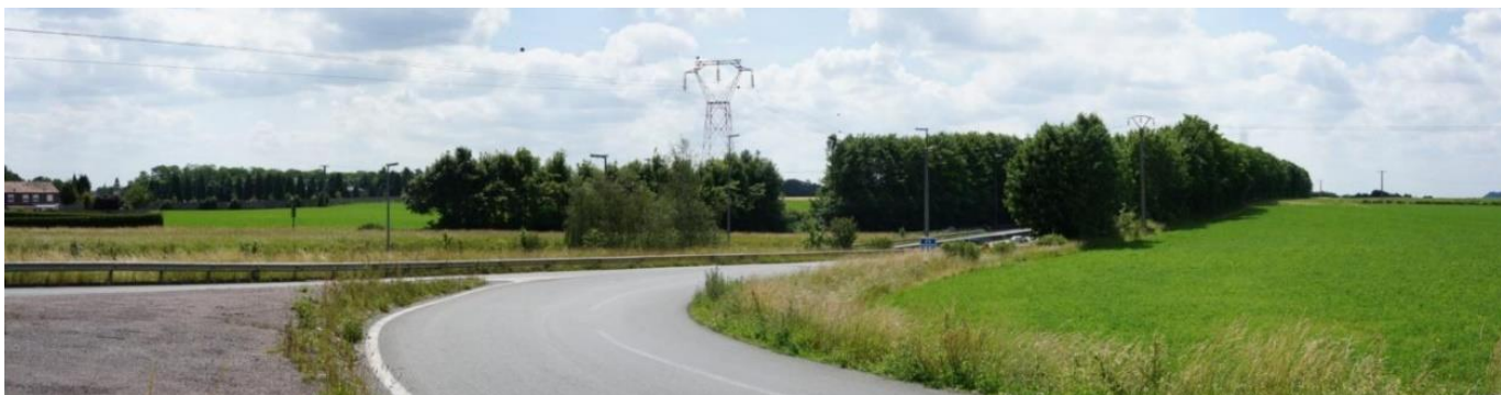
8-A l'entrée de la bretelle de l'A21, et du futur giratoire, les terrils disparaissent derrière les arbres qui longent l'autoroute. La partie est du site du projet se voit depuis cette bretelle d'accès.
