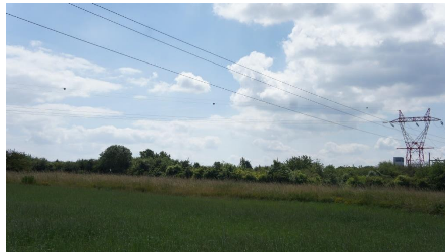
Lignes HT, vue depuis le nord vers l'ouest (Source : Mediaterrre Conseil)
