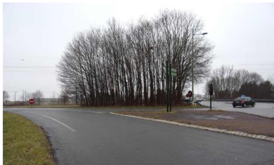
Secteur du giratoire nord de la A21 – Rainette Février 2017.
