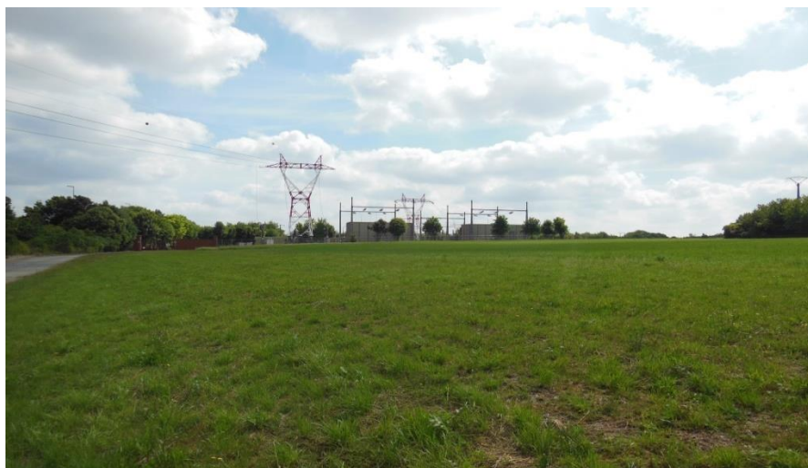
Poste EDF au nord-ouest du site, vue orientée vers le site (Source : Mediaterrre Conseil)
