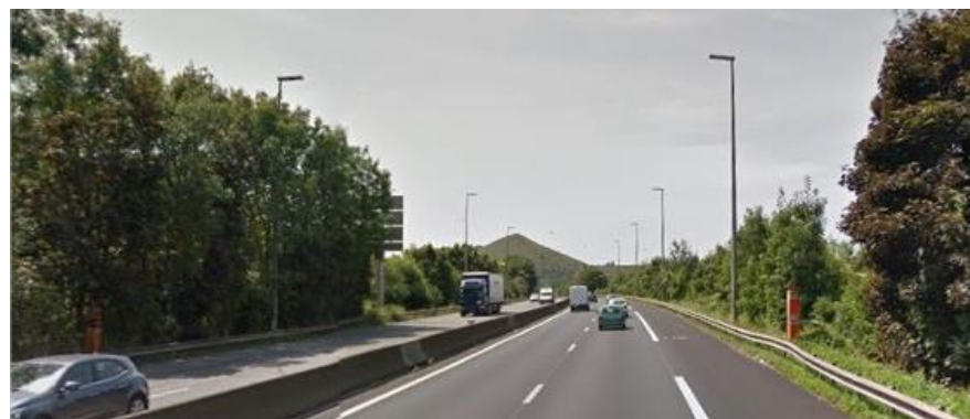
6-Les terrils dans l'axe de l'A21, au niveau de l'extrémité ouest du site.
