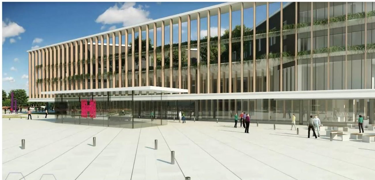
Le hall d'accueil transperce vers la terrasse-jardin.
