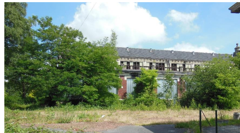
Ancien bâtiment de la salle des pendus et des bains douches de la fosse n°12 de la Compagnie des Mines de Lens (Source : Médiaterre Conseil).
