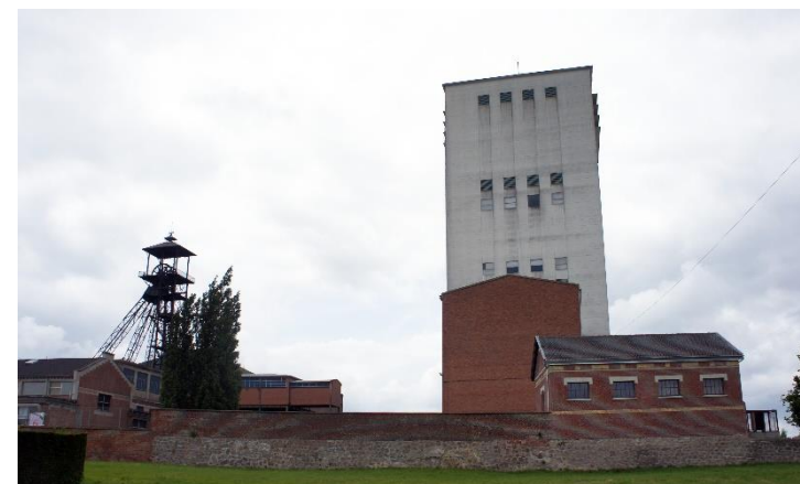
Chevalement de la fosse 11 et tour d'extraction de la fosse 19 (Source : Médiaterre Conseil).
