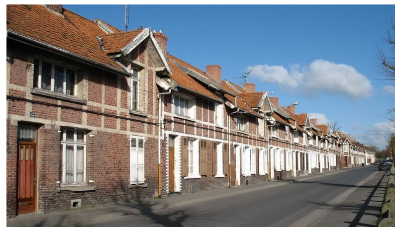
Cité du 12-14 en cours de réhabilitation.
