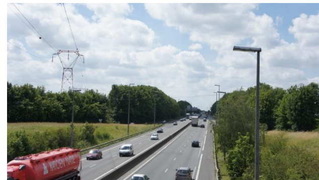
Autoroute A21, vue depuis la route de la Bassée (Source : Mediaterrre Conseil)
