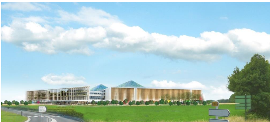
Maintien de visibilité sur les terrils depuis le rond-point d'accès au site (Architectes Michel Beauvais Associés (MBA) – Février 2017).
