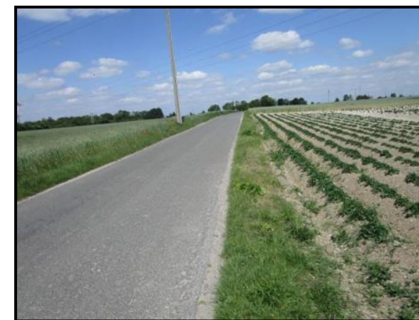
Voiries et bermes associées (Source : Rainette)
