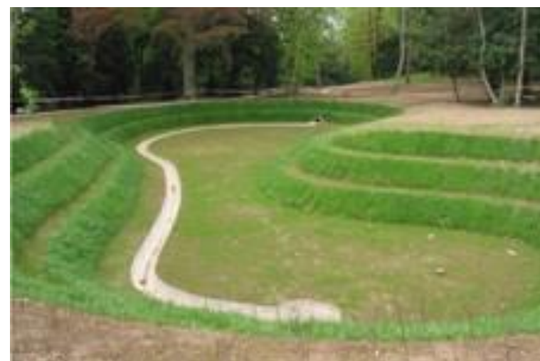
Exemple de traitement autonome des eaux pluviales par bassin d'infiltration avec rejet régulé dans le réseau public pour les orages exceptionnels
